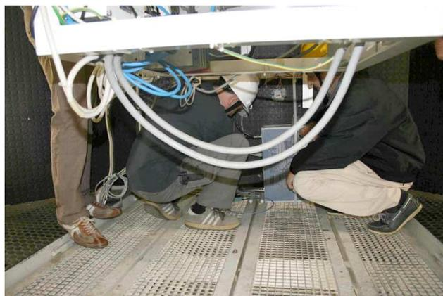
Installazione del down-converter Kuhne per HAM-TV all'interno dell'antenna VLBI da parte di Giuseppe. Emanuele sovrintende le operazioni. Siamo nella stanza posta al di sotto del feed. L'apparato in primo piano, sospeso, contiene lo LNA criogenico (raffreddato ad Elio liquido) in banda S e in banda X.
