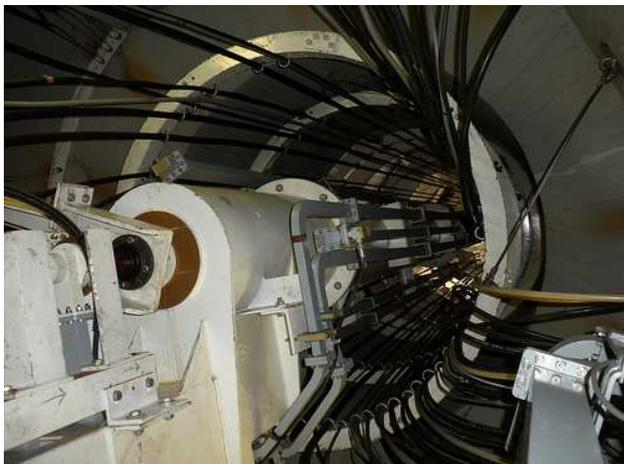
**Telespazio: le guide d'onda e il meccanismo di rotazione di una parabola da 32 metri.**
