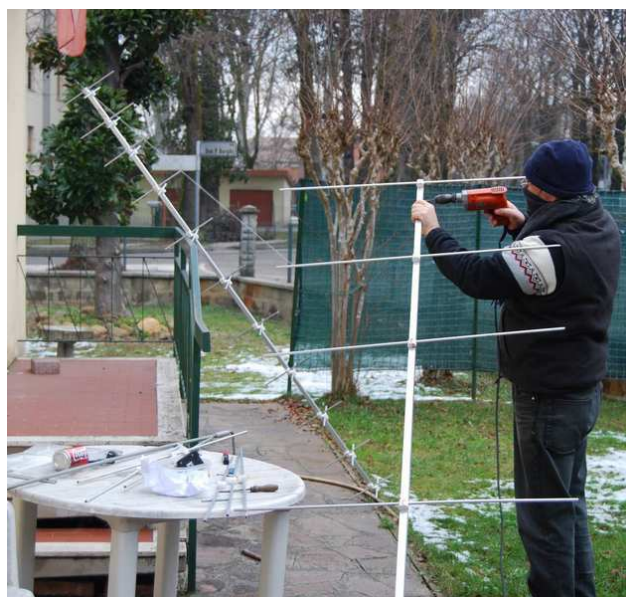
Fig. 1 – Autocostruzione Antenne Satellite (Boris Verzelloni, IK4RSR)
