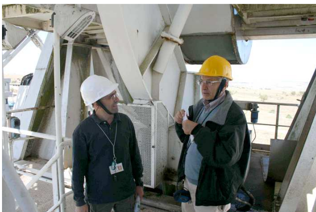
Emanuele IOELE discute con Giuseppe Colucci, tecnico operatore dell'antenna VLBI durante le operazioni per l'installazione del converter in banda S nel cuore dell'antenna.
